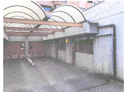
Accès parking souterrain
