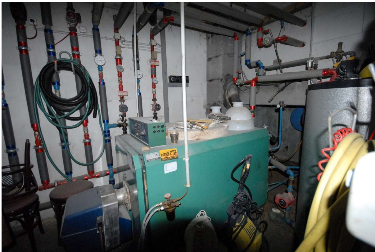
Local chauffage ave chaudière à mazout au rez inférieur
