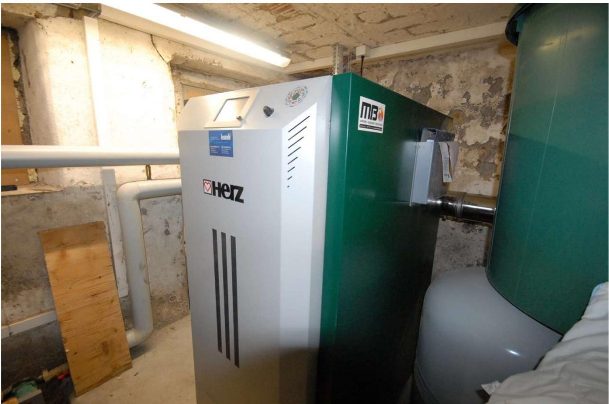
Chauffage à pellets dans le bâtiment de la brasserie, qui alimente également les 4 pavillons
