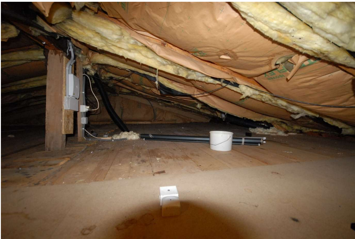
Galetas aux combles avec escalier escamotable
