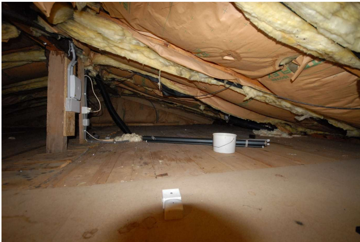
Galetas aux combles avec escalier escamotable
