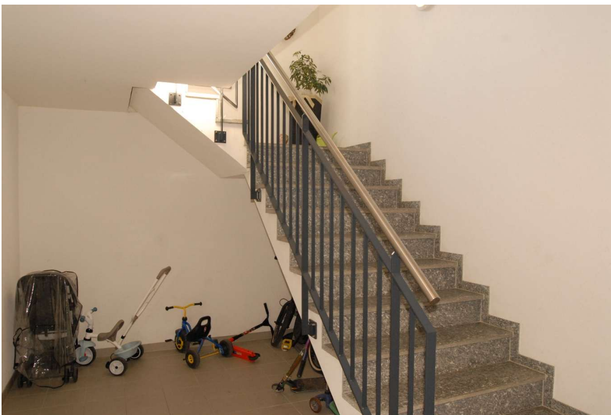
Cage d'escalier de l'immeuble
