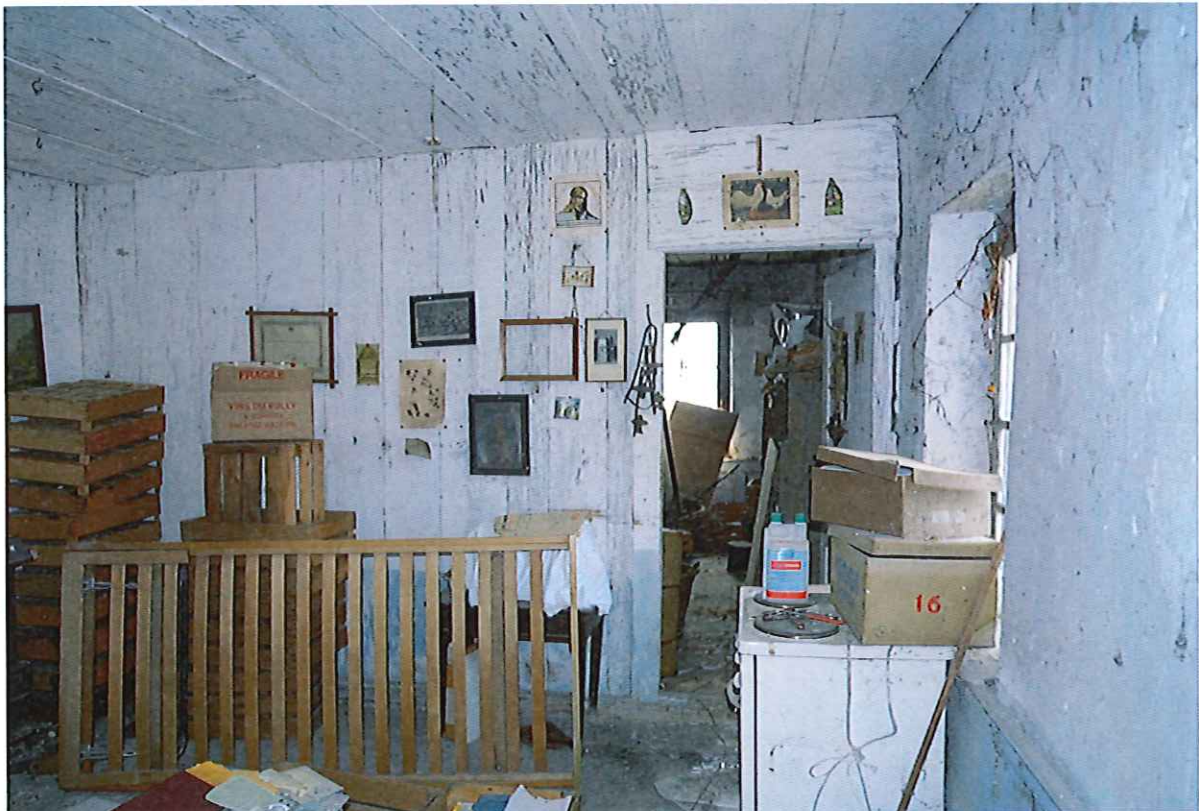
Réduits en enfilade au rez-de-chaussée
