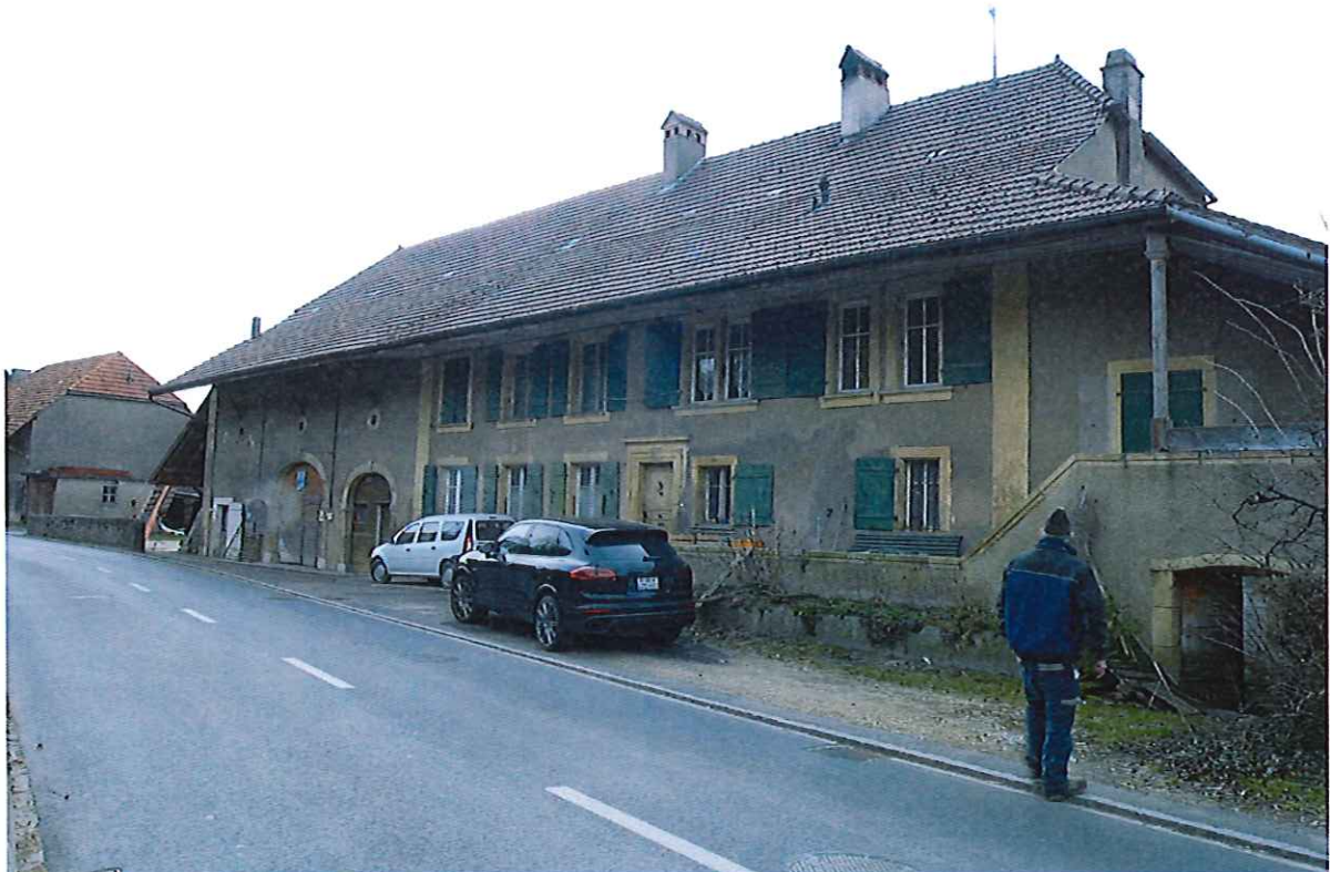
Vue de la façade Nord
