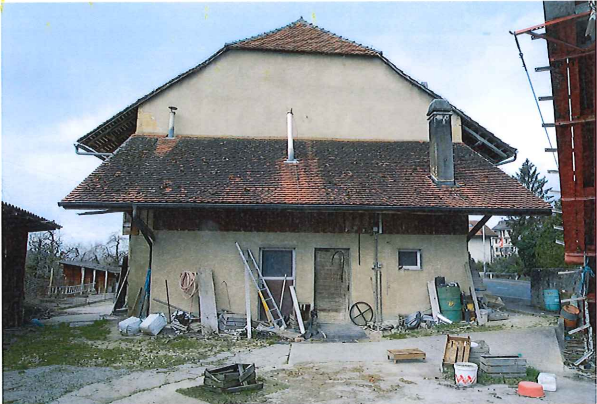
Vue de la façade Est
