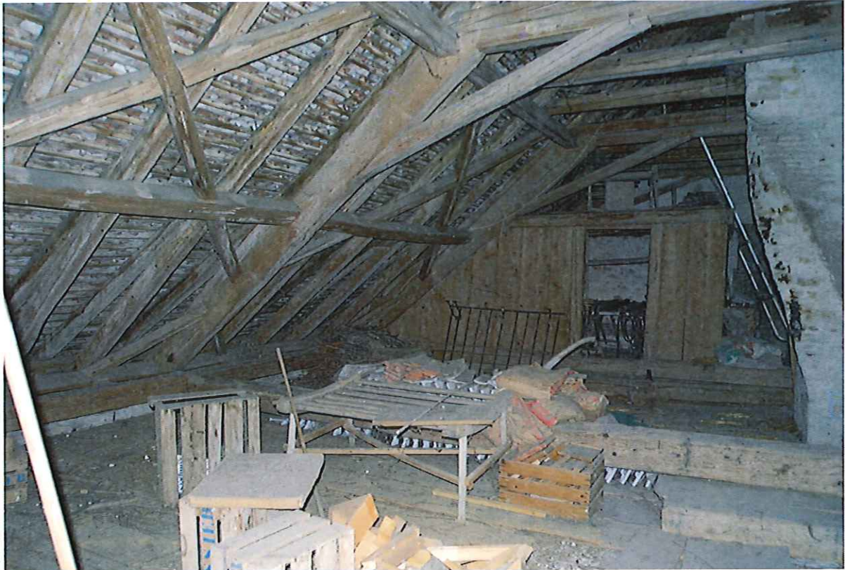
Galets dans les combles
