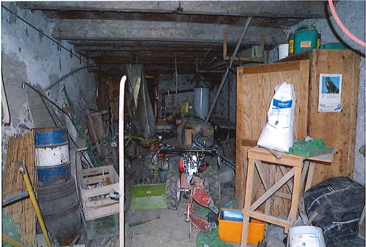
Dépôt au rez-de-chaussée
