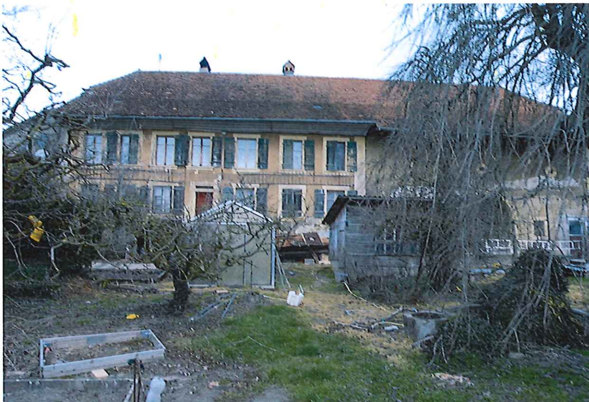
Vue de la façade Sud
