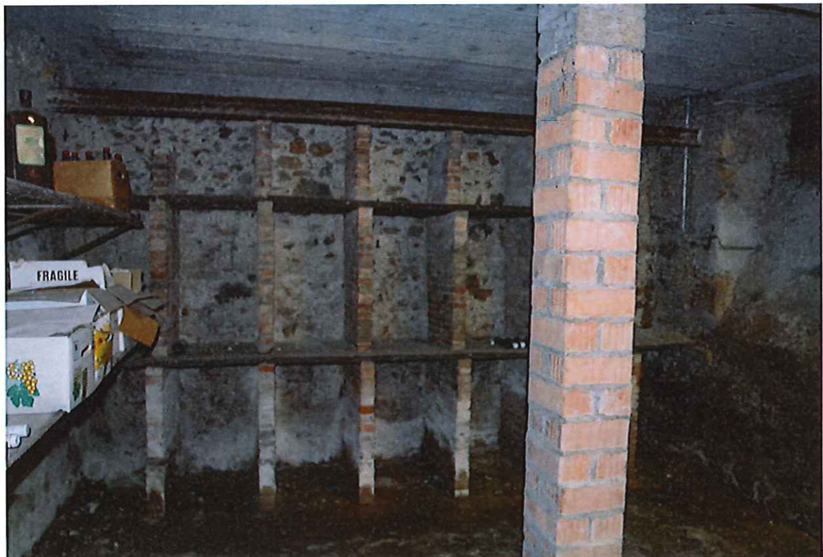
Cave au sous-sol
