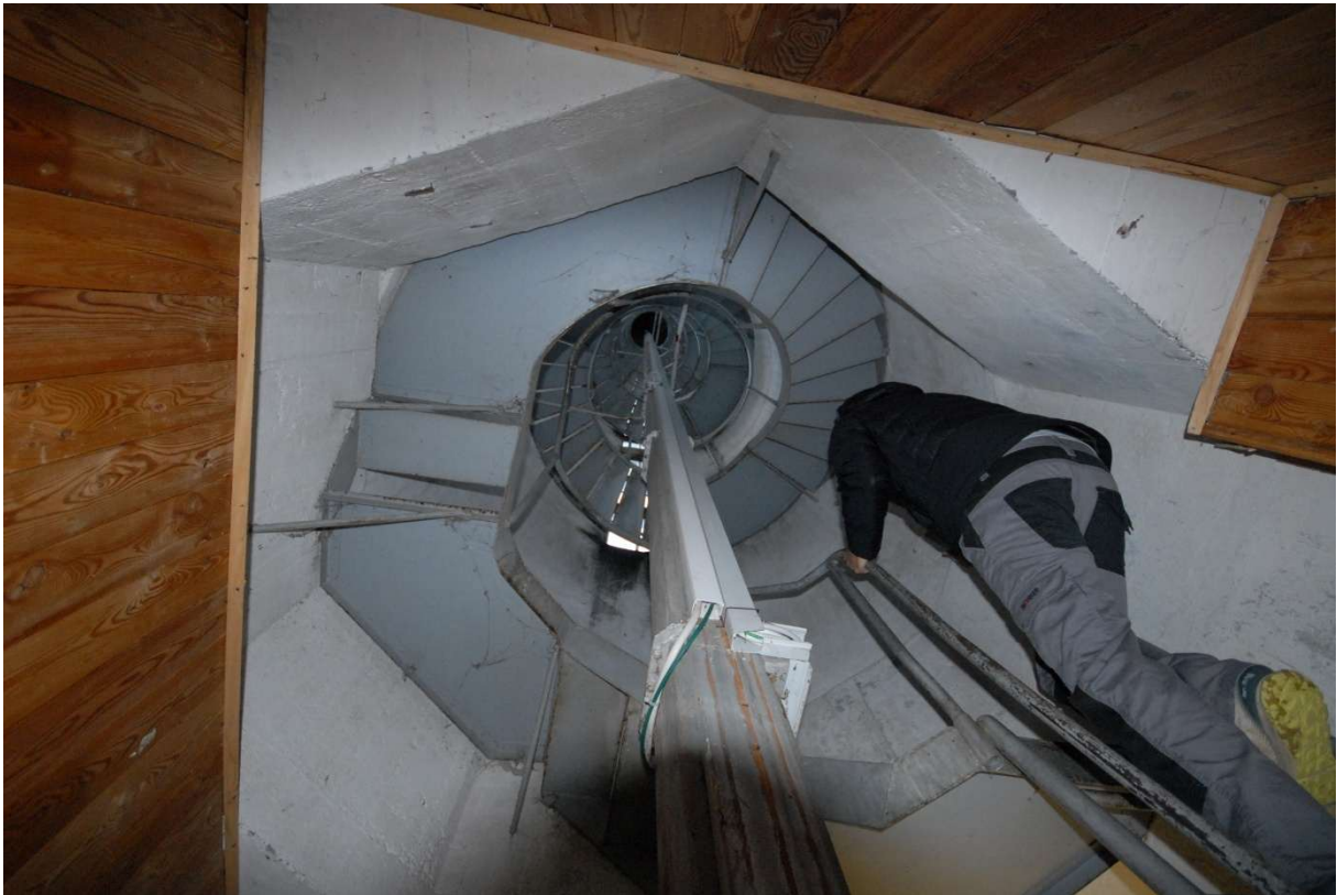
Cage d'escalier hélicoïdal à l'intérieur des silos désaffectés
