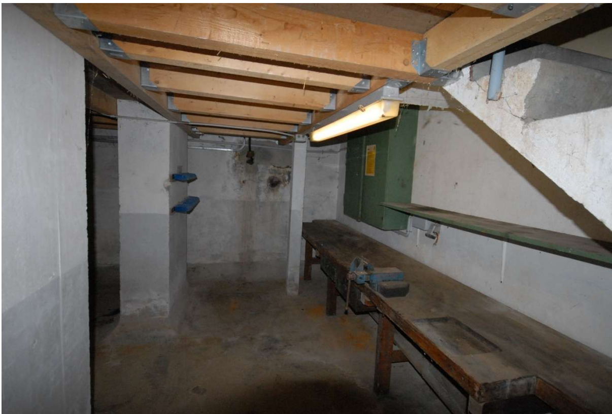
Dépôt, atelier au sous-sol inférieur
