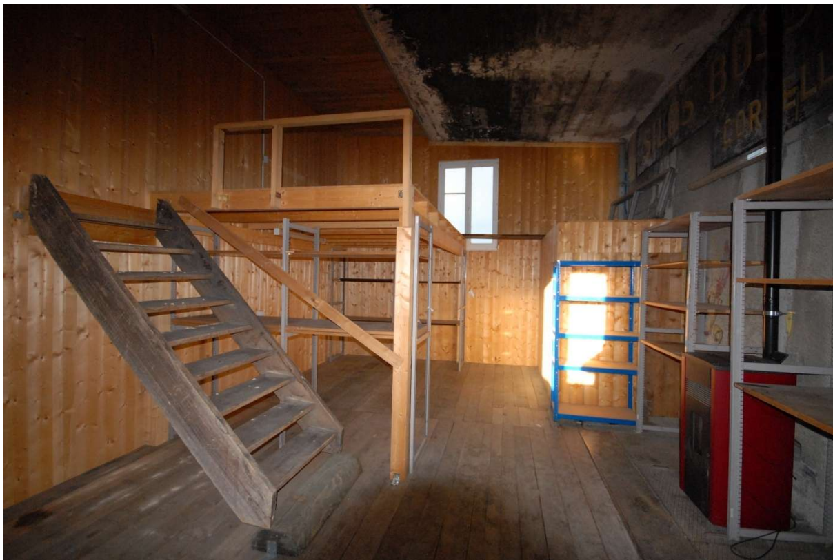
Dépôt à côté de l'espace bureaux au rez-de-chaussée
